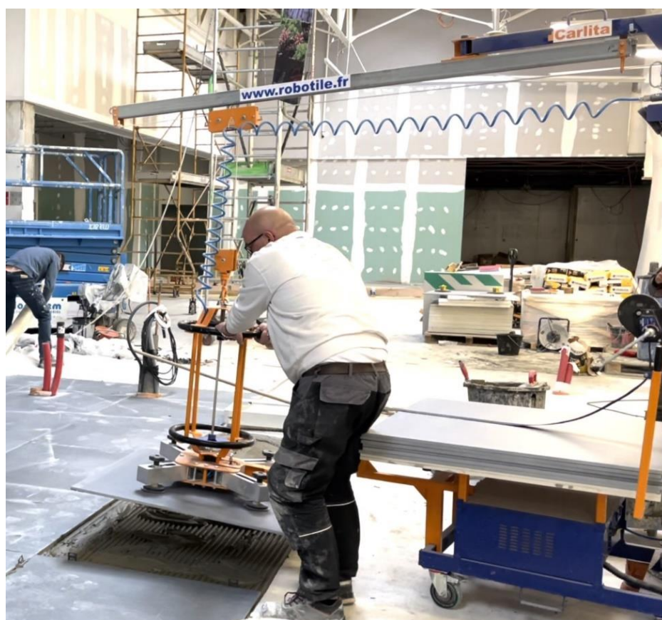
Rys. 18. Układanie płytek przy pomocy manipulatora CARLITA®
